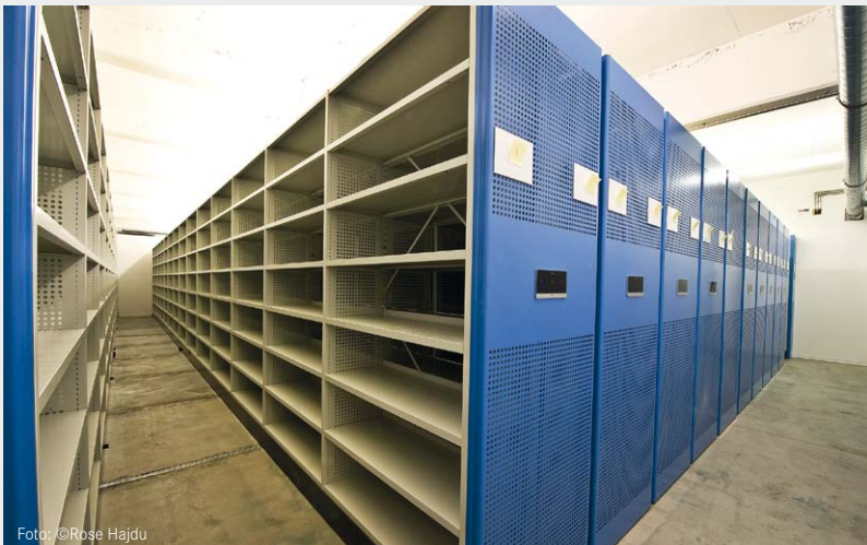
„Haus im Haus“-System mit Gebäudeleittechnik für Grundbuchakten
